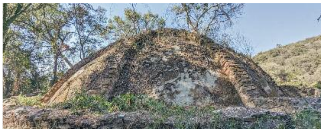
Estat actual del pou de glaç de Can Donadeu, amb arbres a la cúpula. Foto: La Xopera
