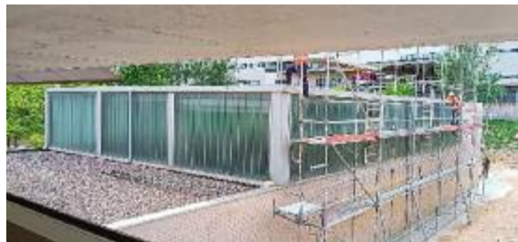
Obres a la teulada del gimnàs de l'escola. Foto: Ajuntament
