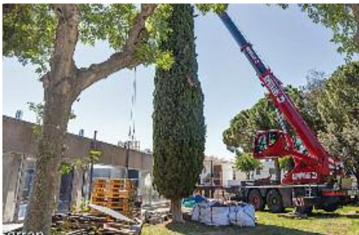
Instal·lació de les noves bigues. Foto: Silvia Ferran/Ajuntament
