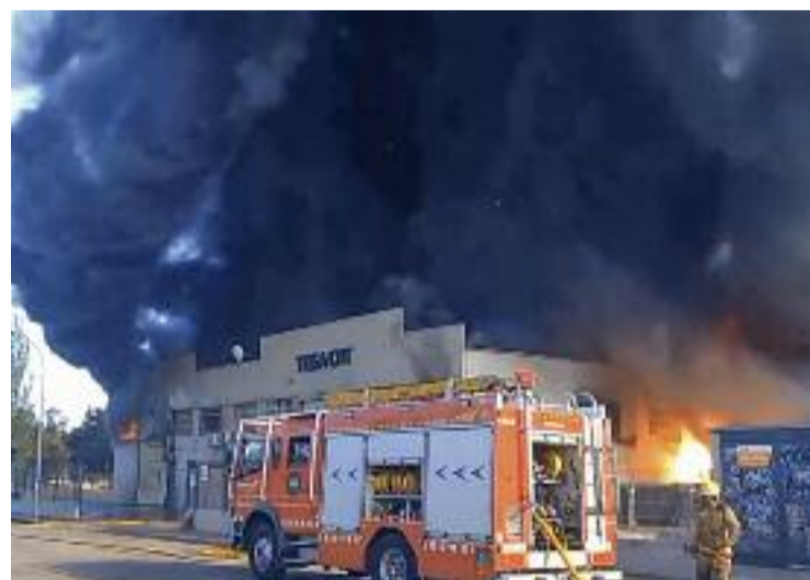
L'incendi va afectar l'interior i la coberta de la nau. Foto: Bombers
