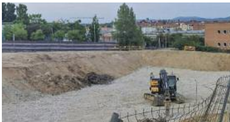
Obres de la nova escola d'infermeria. Foto: Plataforma Sanitat Pública
