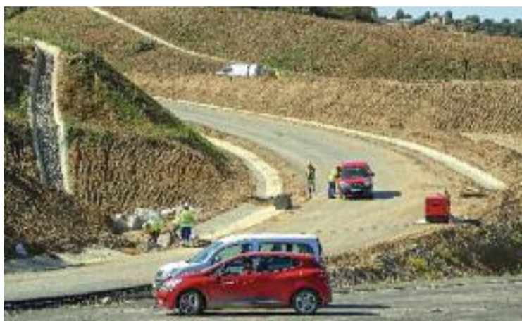
Imatge del tram en obres entre Abrera i Terrassa. Foto: Albert Segura/ACN
