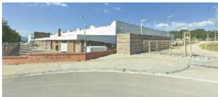
Terrenys de l'antiga Telefònica. Foto: Google Maps
