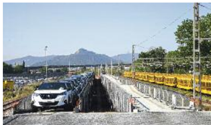
La plataforma de la Llagosta enllaçarà amb la línia Barcelona-França. Foto: Adif
