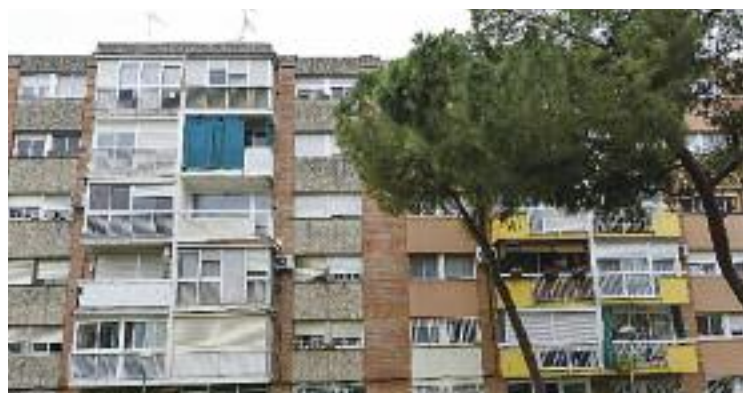
Façanes d'edificis del barri de Can Folguera. Foto: Aj. de Santa Perpètua
