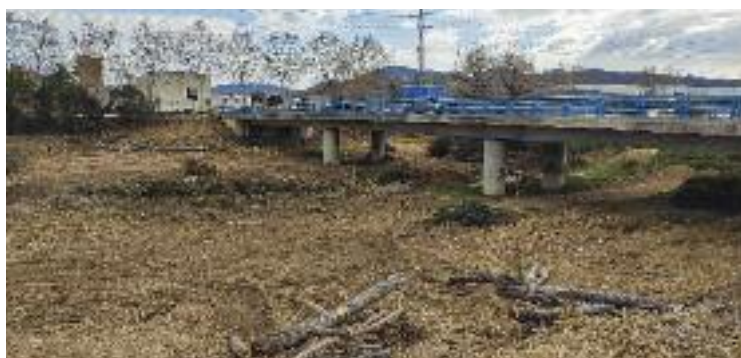
Estat actual de la llera del Tenes al seu pas per Parets. Foto: Ara Parets ERC
