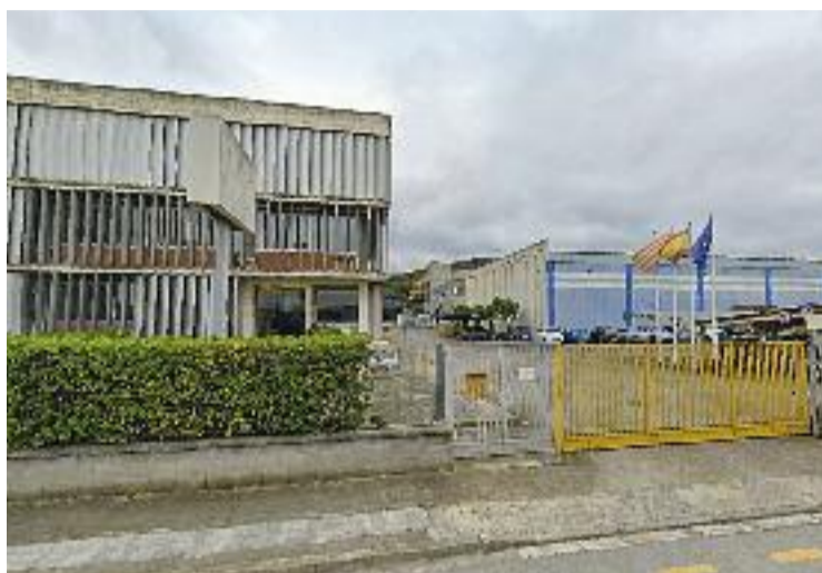
La fàbrica Coveright Surfaces. Foto: Google Maps
