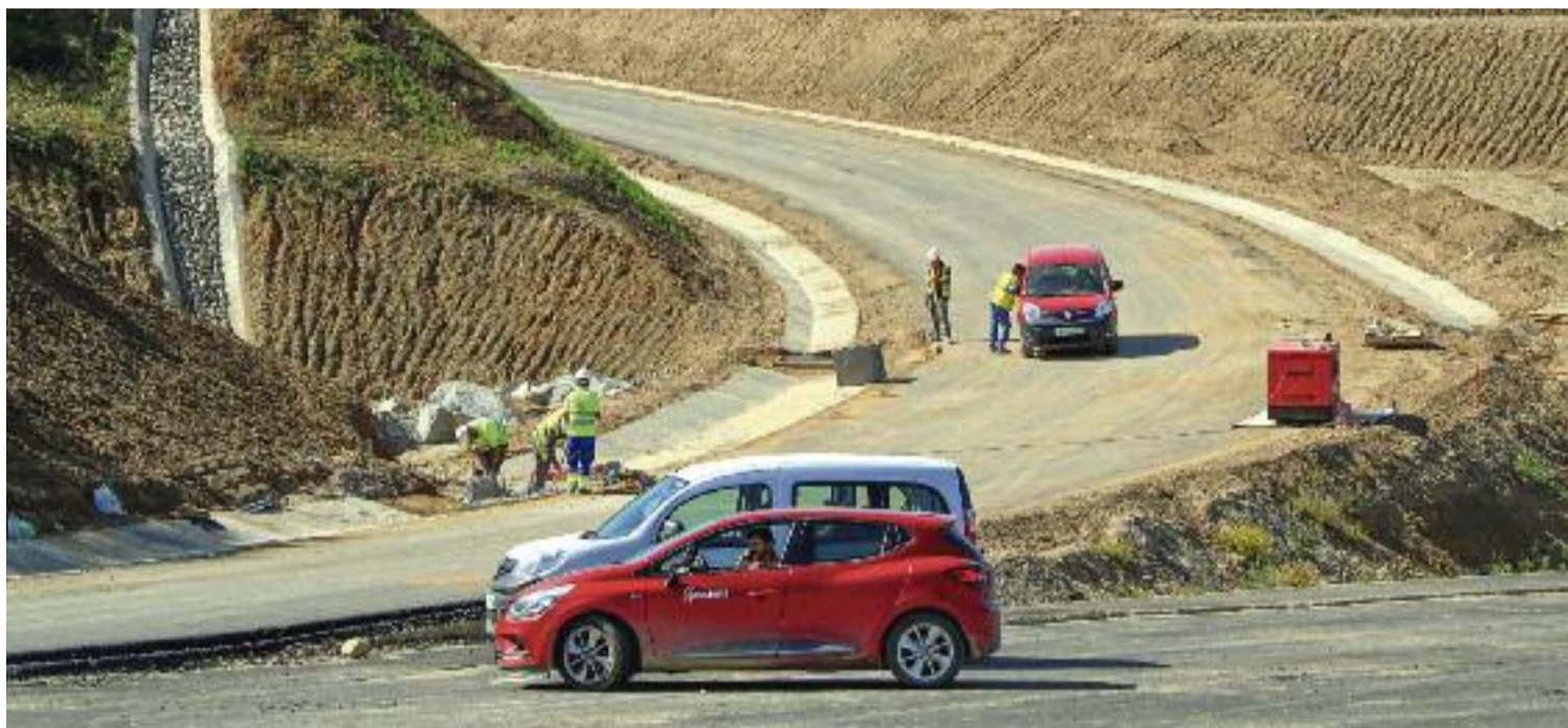
Tram del Quart Cinturó en obres, entre Abrera i Terrassa. Foto: Jordi Pujolar/ACN
