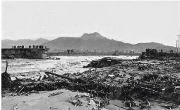
Imatge del pont sobre el riu Ripoll destrossat. Foto: Ajuntament
