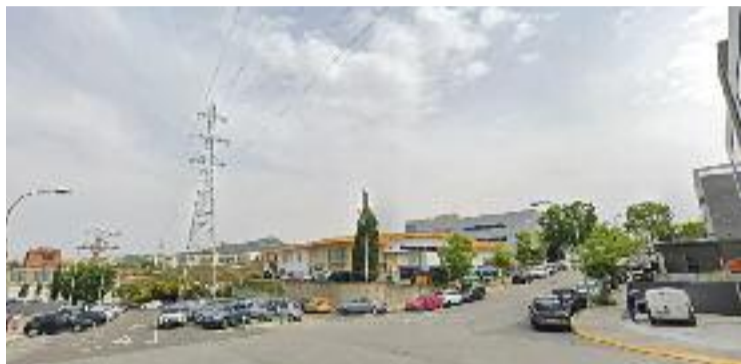
L'avaría ve del carrer de Blasco de Garay. Foto: Google Maps
