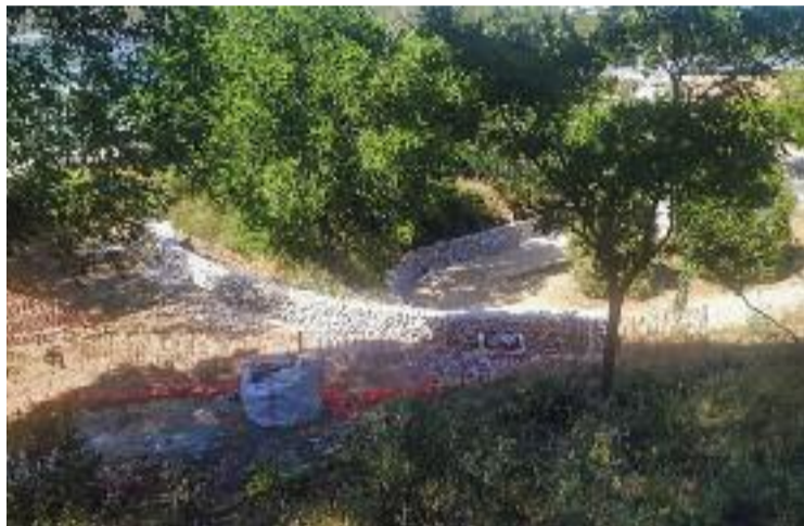
Les obres van començar al març. Foto: Twitter (@ParcOreneta)
