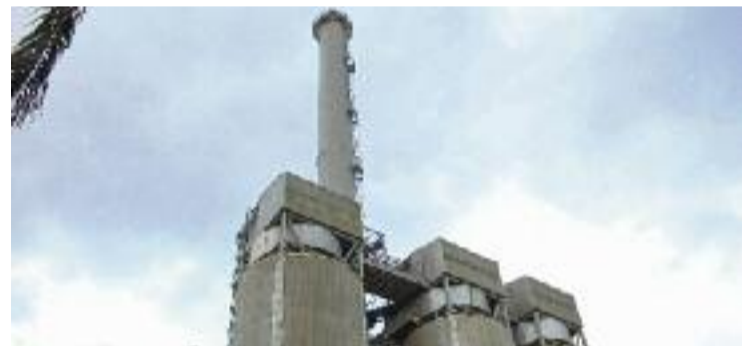
El veïnat denuncia aquest problema des del 2018. Foto: Línia Sant Martí
