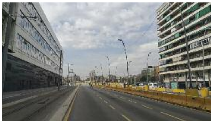
Les obres dels túnels s'han allargat durant set anys. Foto cedida
