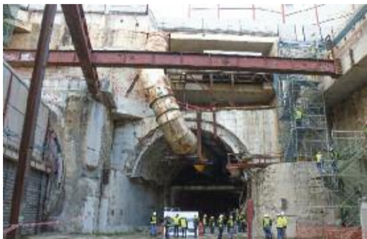
Les obres a l'L9 permetran tapan el pou de la Sagrera. Foto: Lluís Sibilis/ACN
