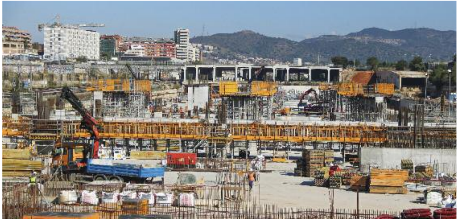
Les obres de la futura estació de l'AVE acumulen anys de retard. Foto: Ajuntament
