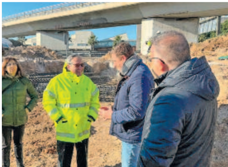
L'alcalde, Jesús Naharro, durant una visita a les obres. Foto: Ajuntament
