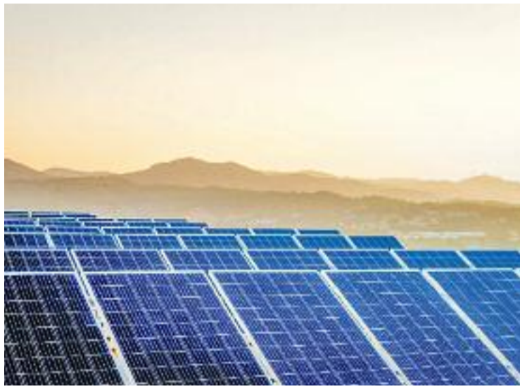
Plaques solars a les instal·lacions de l'empresa. Foto: Ajuntament
