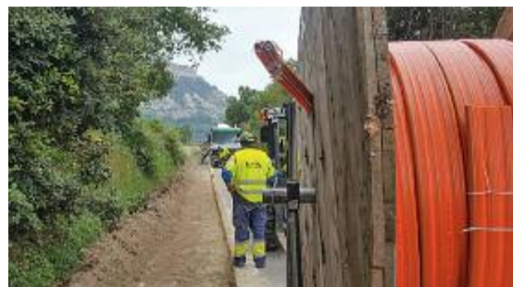
Obres de desplegament de la xarxa de fibra òptica. Foto: Diputació de Barcelona
