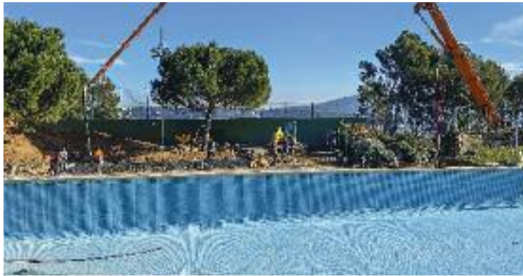
Construcció de la nova piscina descoberta. Foto: Ajuntament
