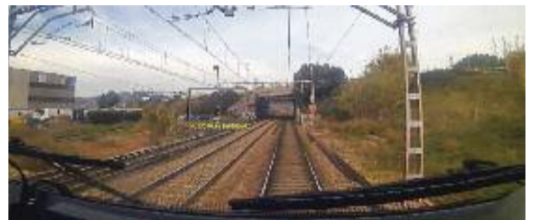
Ubicació del futur pas inferior sota l'AP-7. Foto: Adif
