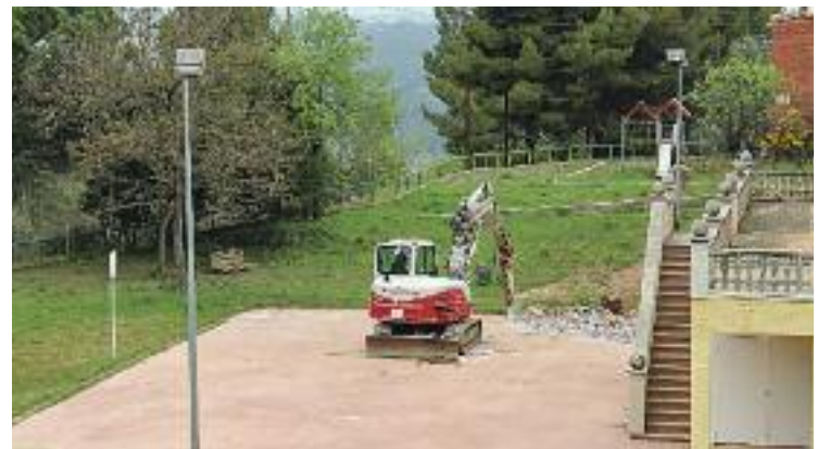
Les primeres obres per construir la piscina. Foto: Aj. Castellví
