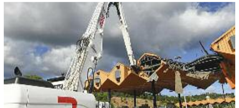
La retirada de l'estructura d'un peatge. Foto: Twitter (@raquelsjimenez)
