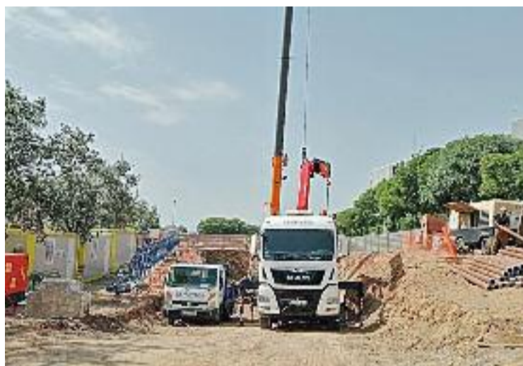
Inici de la construcció dels pisos. Foto: Ajuntament de Montgat
