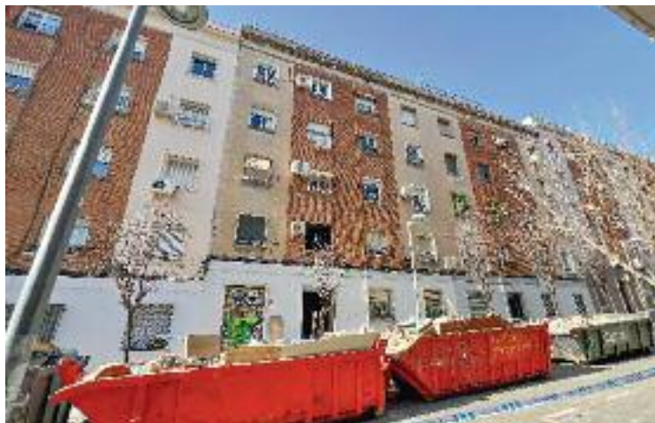
Exterior dels pisos del carrer Canigó. Foto:Jordi Pujolar/ACN
