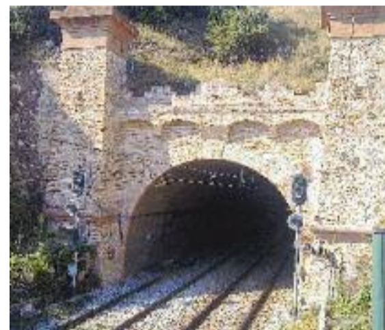
El túnel de Montgat, l'abans i l'ara. Fotos: Ajuntament de Montgat i Arxiu
