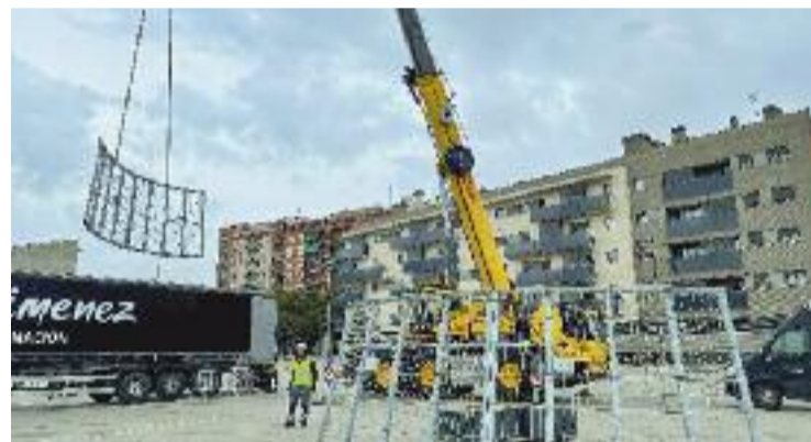
Imatge de l'inici del muntatge de l'arbre. Foto: Jordi Pujolar / ACN
