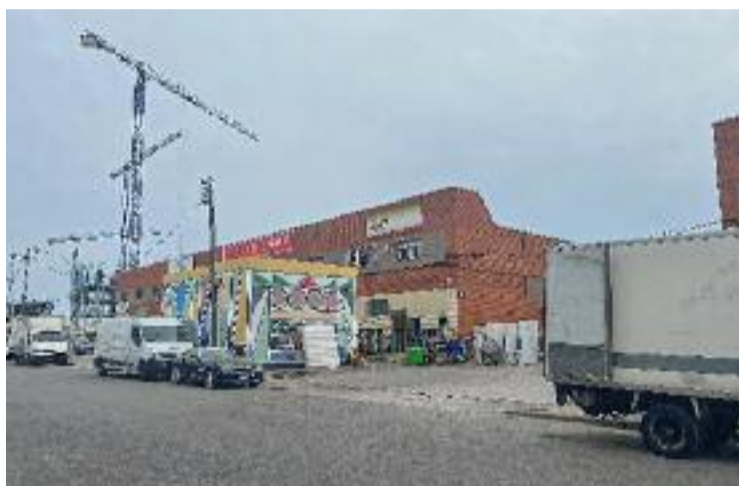
Exterior de la nau ocupada al carrer Antoni Bori. Foto: Línia Nord
