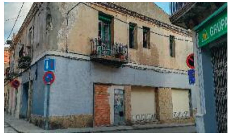
Una de les edificacions afectades pel PERI. Foto: Twitter (@societatvella)
