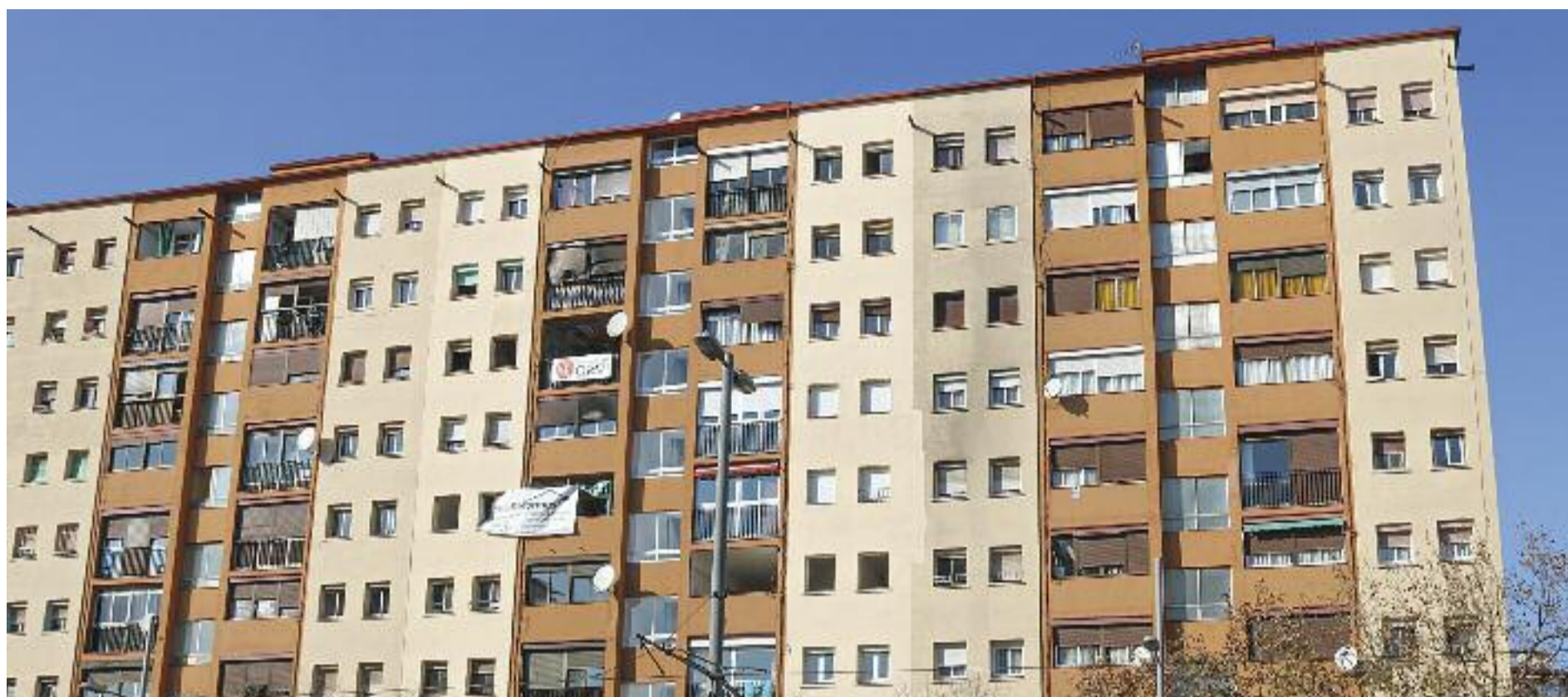
Sant Roc és el barri de la ciutat on el problema amb l'estat d'alguns blocs de pisos és més greu. Foto: ACN
