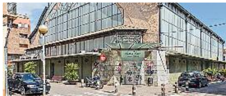
Façana del mercat Torner. Foto: Arxiu
