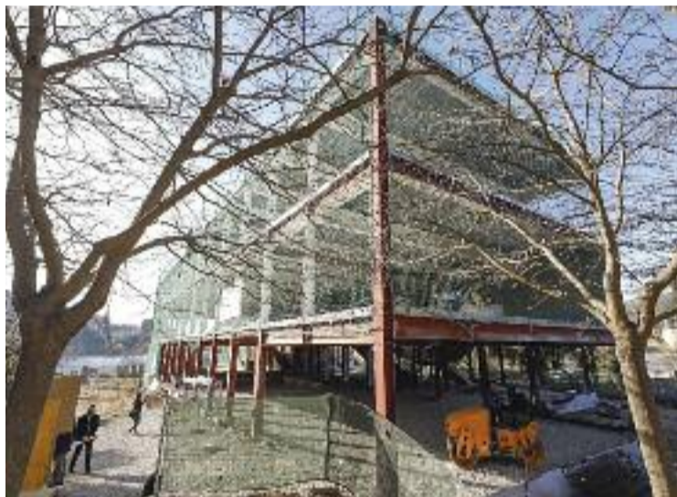
Un dels nous edificis en construcció al recinte Torribera. Foto: Diputació
