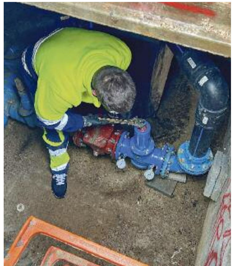
Imatge d'arxiu d'un operari en una canonada. Foto: Jordi Pujolar/ACN
