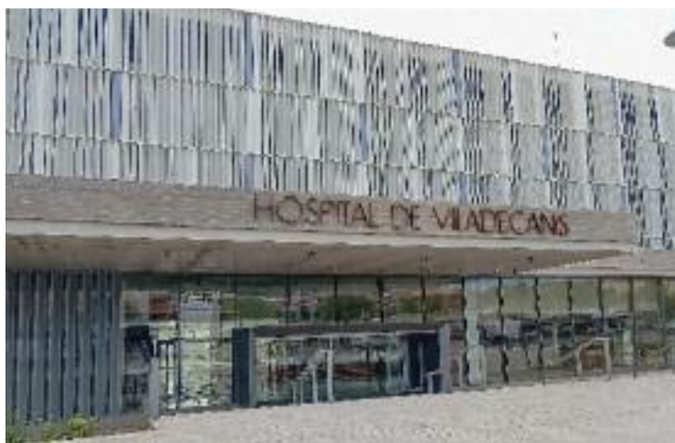
Façana del nou edifici de l'hospital, ubicat al costat de l'antic. Foto: Línia Mar
