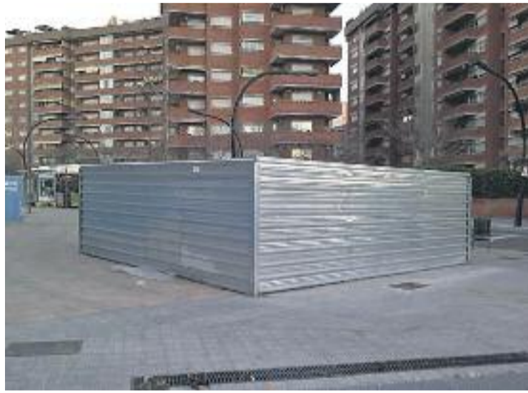
Les obres de l'estació es reprendran a mitjans de l'any que ve. Foto: PP
