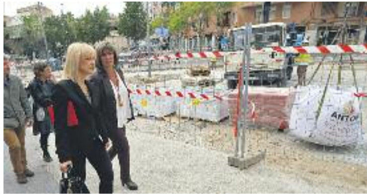
Marín i Díaz durant la visita a les obres. Foto: Ajuntament
