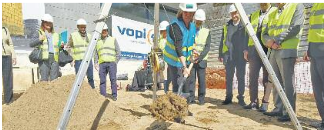
Col·locació de la primera pedra de l'hotel d'easyHotel. Foto: Ajuntament
