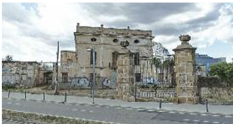
El deteriorament de Can Rigalt no s'atura. Foto: Twitter (@ireneuc)
