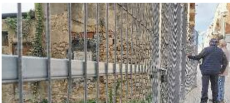
Les obres de consolidació de l'estructura començaran aviat. Foto: Línia LH
