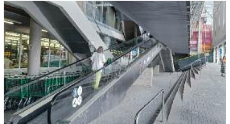
Aspecte actual de les noves escales mecàniques. Foto: Ajuntament
