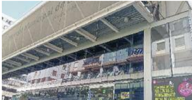
Una lona cobreix la tercera planta, on s'estan fent les obres. Foto: Línia L'H
