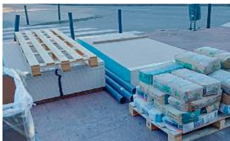
Sacs de ciment i material d'obra a la porta del pis en obres. Foto: AVVIB
