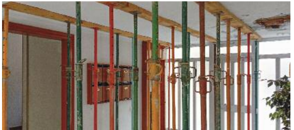
Vista parcial dels apuntalaments del vestíbul del número 7 del carrer de Sant Eugeni. Foto: Línia L'H
