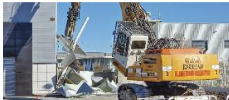
Els treballs comencen amb l'enderroc d'un edifici del recinte. Foto: Fira
