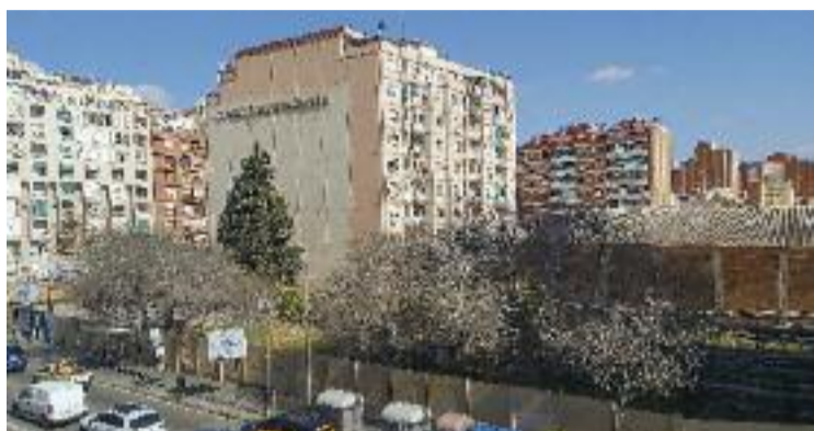
El solar on ha d'anar el centre mèdic. Foto: Línia L'H
