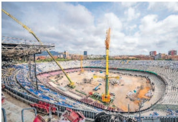
Les obres de l'estadi continuen avançant. Foto: FC Barcelona
