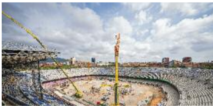
Aspecte de l'interior del Camp Nou durant la remodelació. Foto: Barça
