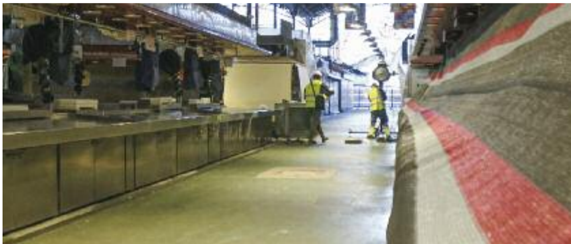
Les obres per canviar el paviment de la Boqueria van començar el 16 de gener. Foto: Norma Vidal/ACN
