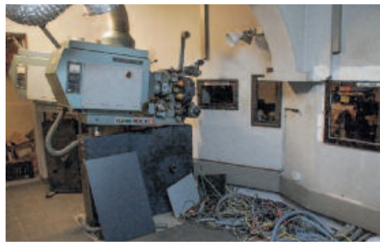
Un dels projectors que conserva l'edifici. Foto: X (@victorbaldovi)
