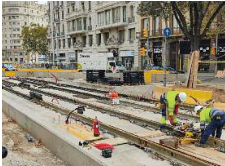
Les obres del tramvia de la Diagonal continuen avançant. Foto: Ajuntament
