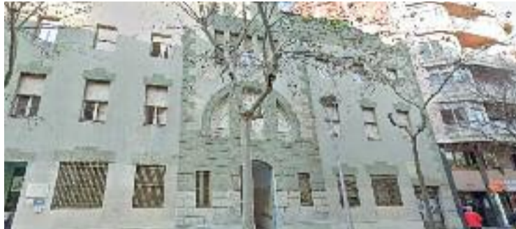
L'edifici del carrer de Provença, 389. Foto: Google Maps
