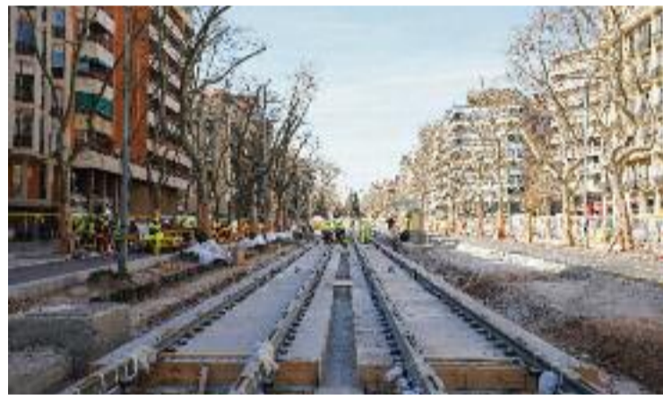
Les obres del tramvia provocaran nous talls de carrers. Foto: Ajuntament
