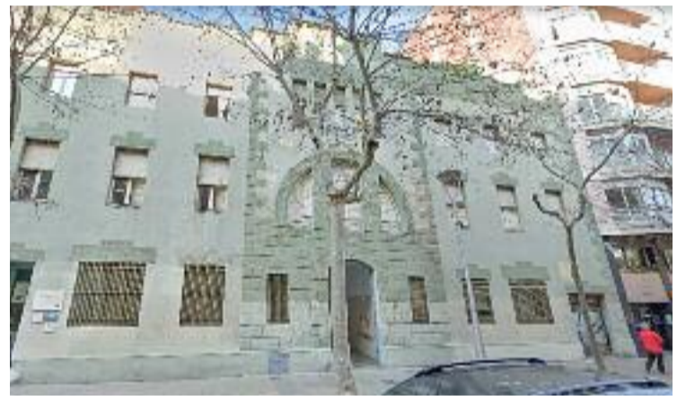
L'edifici del carrer Provença que l'Ajuntament ha comprat. Foto: Google Maps
